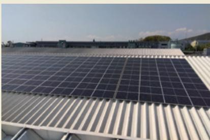
美濃加茂第3工場の屋根に太陽光パネルを設置しました。これにより発電した電力は、美濃加茂事業所内の設備へ即時供給されるシステムとなっています。美濃加茂事業所は塗装設備や大型集塵機に多くの電力を使用することから、発電電力の自家消費により電力費を少しでも削減し、環境負荷の低減に貢献するため当該設備を導入しました。2023年4月より稼働しており、美濃加茂事業所全体にかかる電力の1割程度を太陽光発電でまかなっています。
