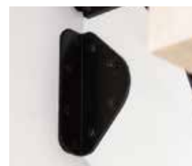
柎と壁の固定
